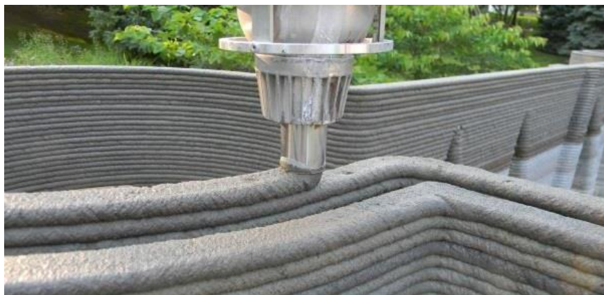
Figur: Det finnes allerede i dag ulike metoder for 3D printing. Bildet viser printing ved en rammemontert dyse. Andre metoder er printing ved bruk av en frittstående robotarm eller mobile roboter (Kilde: www.designingsbuildings.co.uk ).
