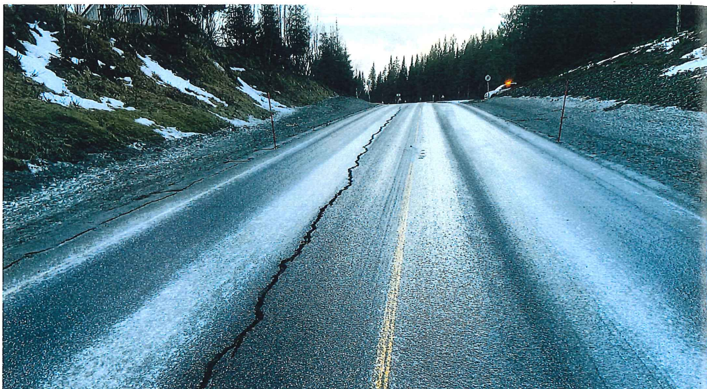
DÅRLIG. Strekingen E6 Fjerdingen-Grøndalselv er svingete, i dårlig stand, og den oppfyller ikke dagens krav til veibredde for europavei. Rett etter påske startet byggingen av ny E6 som er planlagt for 90 km/t. Foto: Geir Skjold-Johnsen, Statens vegvesen
